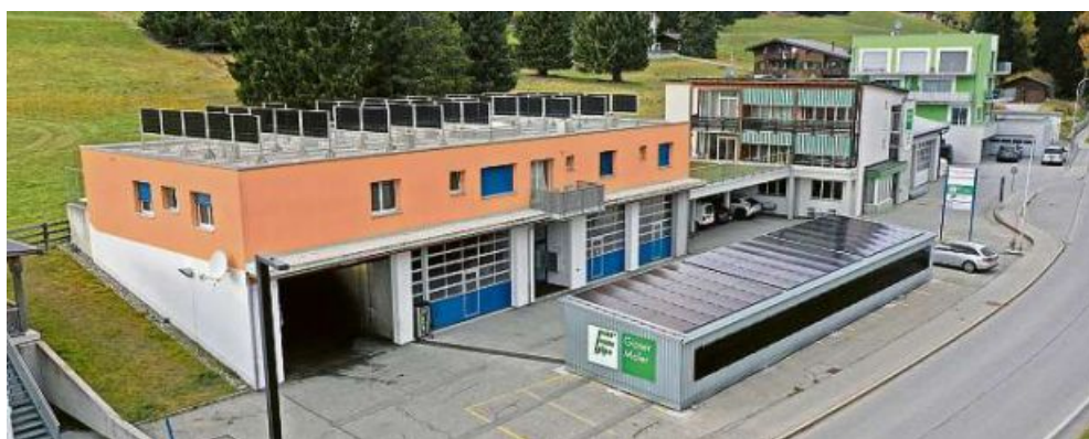
Die Parpan Gips AG an der Voa Nova in Lenzerheide setzt auf eigene Stromerzeugung.
